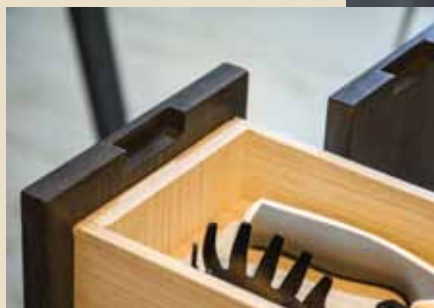
Pengerjaan coakan pada pintu kabinet cukup sulit mengingat material pelapis berupa HPL yang kaku.
